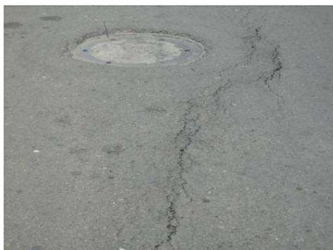
Foto N° 22. Se evidencia en este tramo que existe deterioro profundo de la carpeta, presentándose fisuras y grietas longitudinales en la carpeta asfáltica
