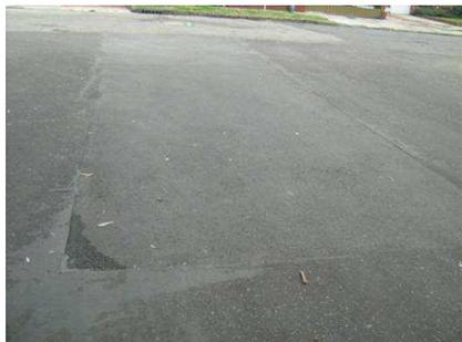
Foto N° 7. En este tramo se evidencia que se ha realizado parcialmente el reemplazo de la mezcla con reparcho.
