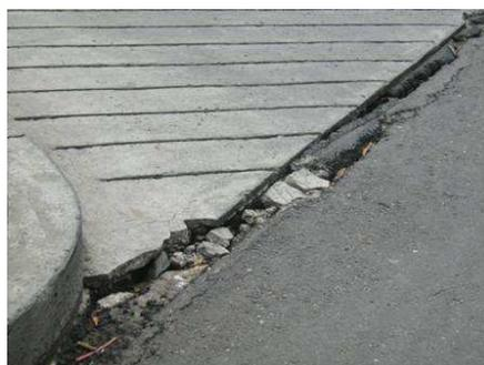
Foto 24. Se observa que esta falla no es superficial, ya que se evidencia desprendimiento de la parte opuesta a la carpeta vegetal del costado sur del tramo.
