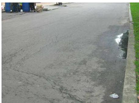
Foto N° 23. Se observa que estas fisuras están dadas por el hundimiento causado por la depresión por la afectación de los cuerpos vegetales (árboles) aledaños a la vía.
