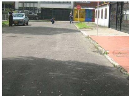
Foto N°8. Tramo Calle 24 D entre Cra 44ª y 45. En este tramo es mayor el desgaste en el costado sur del tramo, en donde se evidencia desgaste acelerado con abultamientos y desprendimientos de la carpeta asfáltica.
