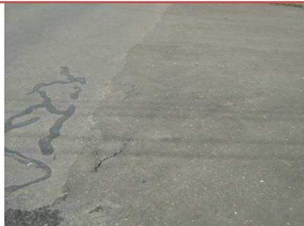
Foto N° 13 y 14 Calle 22 Bis entre Cra 44 A y 44 B. presenta desgaste en la zona de traslape en donde se presenta alto grado de cargas dinámicas transversales por la circulación vehicular.
