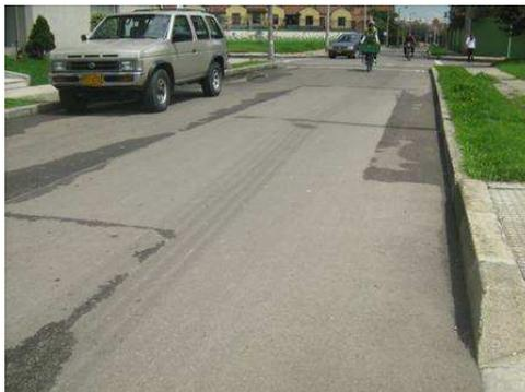
Foto N° 20. Se evidencia igualmente remplazo parcial de la carpeta deteriorada.
