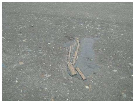
Foto N° 11 y 12 Se evidencia en este tramo que se han realizado reparachos reemplazando parcialmente la mezcla, la cual muestra alto grado de desgaste superficial.
