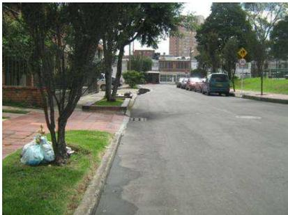
Foto N° 3. Se evidencia que el nivel del sumidero esta levemente por encima en la zona central y no se garantiza en su totalidad la circulación de agua superficial.
