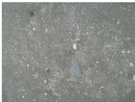
Foto N° 9.y 10..Tramo entre la Calle 22 Bis entre Cra 44 A y 44 B, en este tramo se evidencia igualmente de manera transversal a la vía el desgaste acelerado de la mezcla adicional a agrietamiento en algunos tramos.
