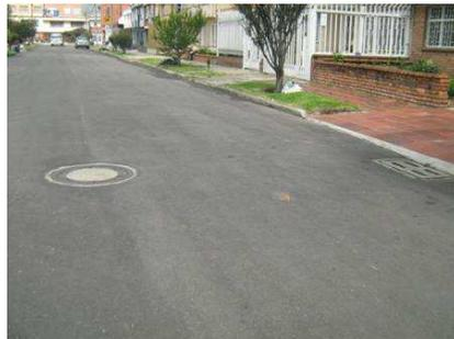
Foto N° 4. En este tramo se observa alto desgaste en aproximadamente un tramo de 30 m en el costado sur, en donde se evidencia la diferencia de la mezcla asfáltica, la cual presenta alto grado de degradación y segregación superficial por cargas dinámicas..
