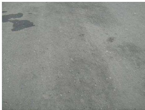
Foto N° 17. En este tramo se evidencia igualmente deterioro acelerado y desgaste de la carpeta asfáltica
