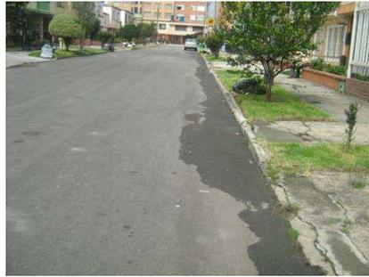
Foto N°2. Se evidencia en este tramo, deterioro de la carpeta asfáltica por apozamiento de agua.
