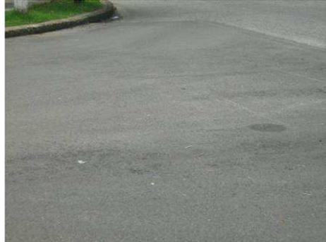
Foto N° 26. En este tramo se evidencia igualmente deterioro superficial de la carpeta
