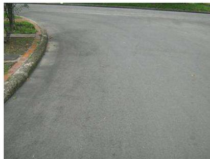
Foto N° 28. El desgaste se acentúa en la parte del cruce transversal vehicular..
